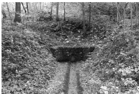
Quellfassung des Brunnens neben der ehemaligen Ortschaft Hofbuchberg.
